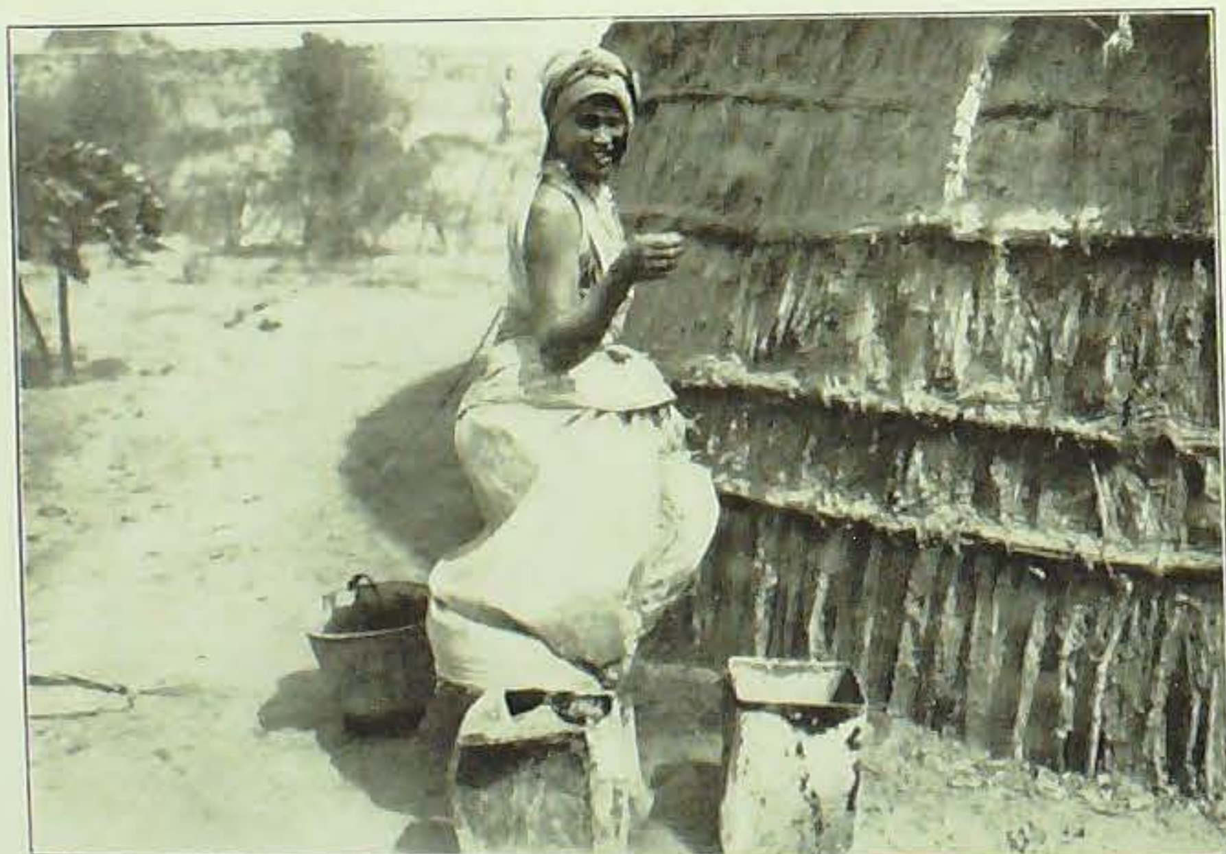
COSTRUZIONE DI CASE INDIGENE.
