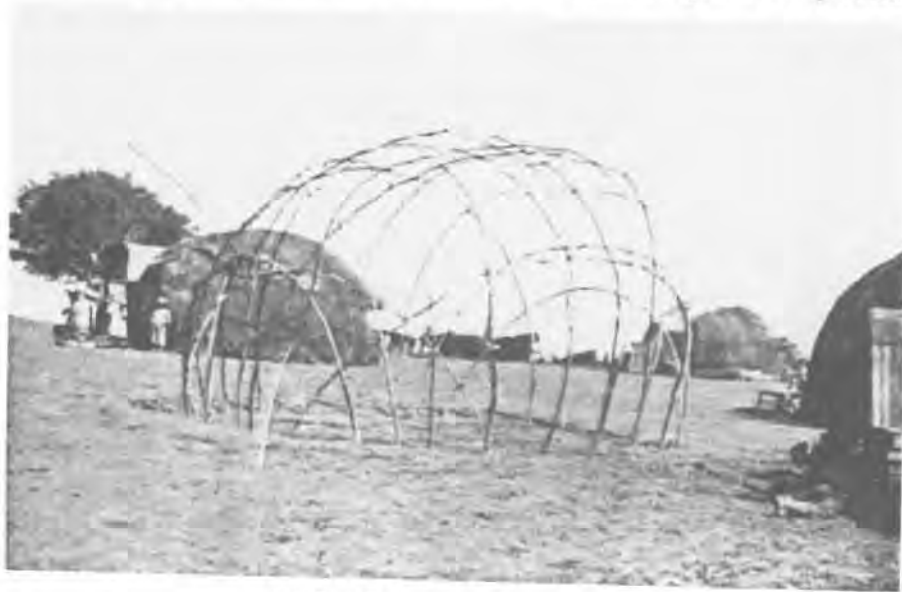
16. Das Gerüst für eine Namahütte.
