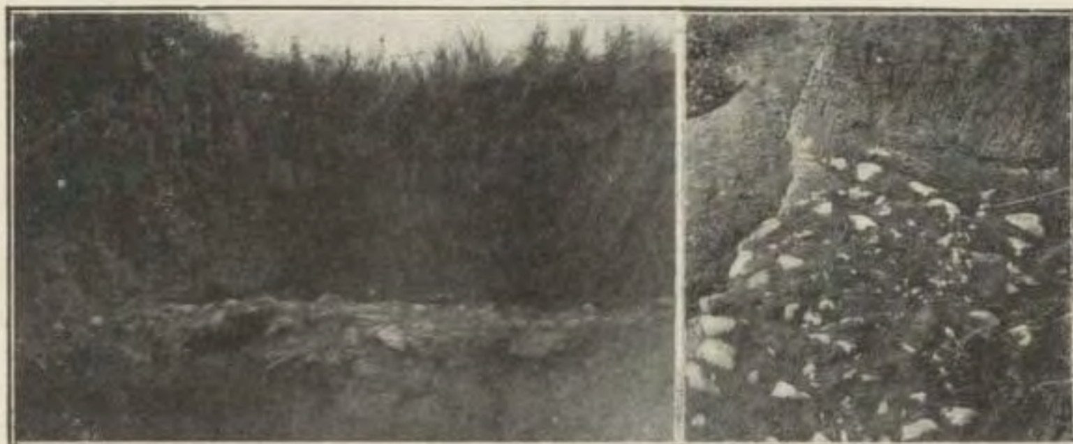
Fig. 21. Photographie de la route romaine au point 1 du plan fig. 10. a. coupe de la route, b. la route prise d'en haut avec le gros pavage qui est une réfection peut-être postromaine de la route en dalles sous-jacente. Vues prises par les auteurs en 1927.
